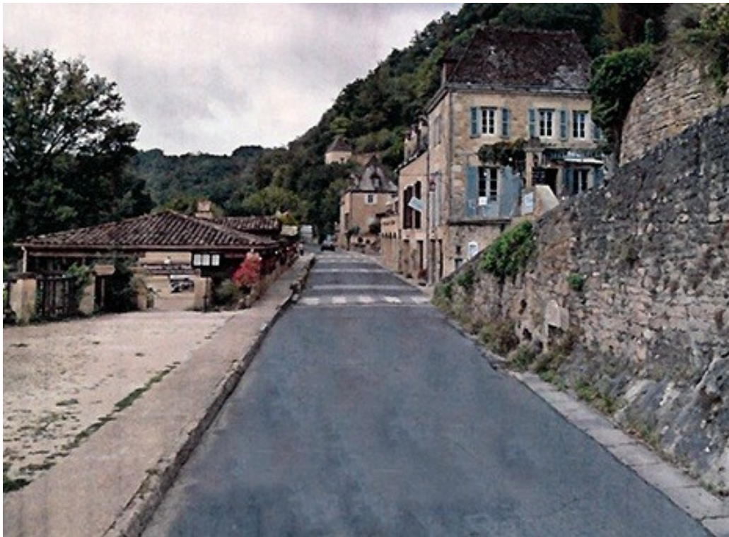
À gauche côté Dordogne, les bâtiments de restauration et l'espace routier contraint, avant travaux, vue vers l'ouest. Source Google street view
