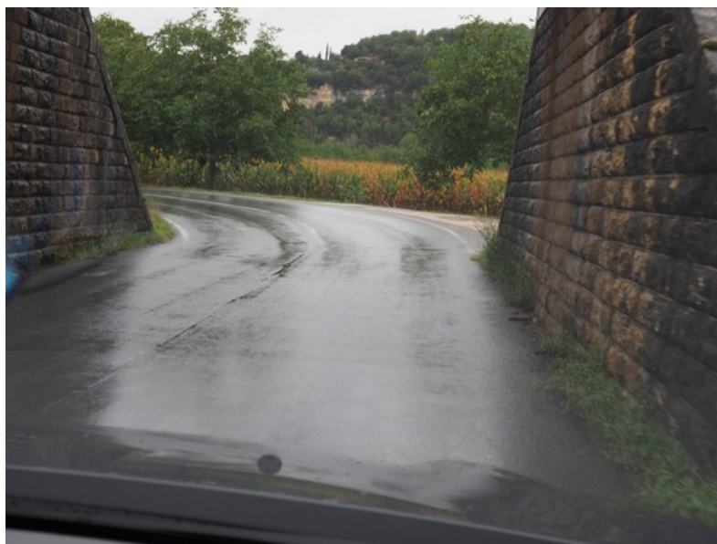
Vers la sortie du pont sous la voie ferrée, de Vézac vers Beynac, un gabarit limité contraint par le virage en sortie, photo mission
